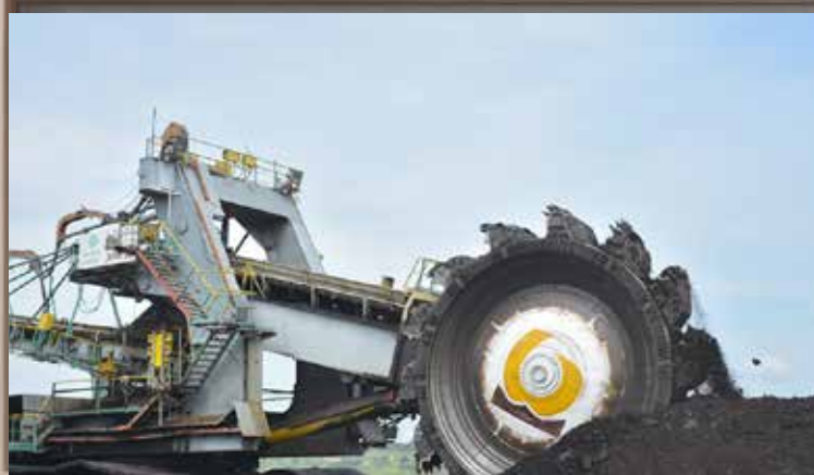
Proyek Pembangunan Pabrik Feronikel Haltim (F3FH) Feronikel Haltim Factory Construction Project (PT Bukit Asam Tbk)
