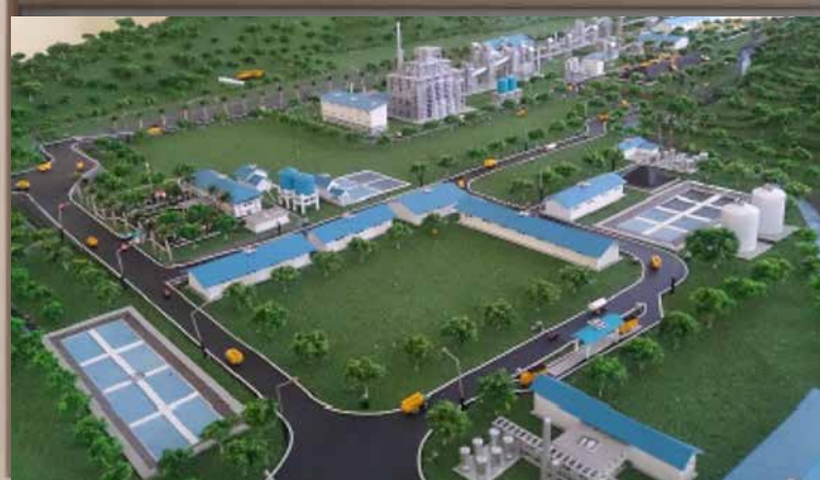
Proyek Pembangunan Pabrik Feronikel Haltim (F3FH) Feronikel Haltim Factory Construction Project (PT Indonesia Aluminium Alloy)
